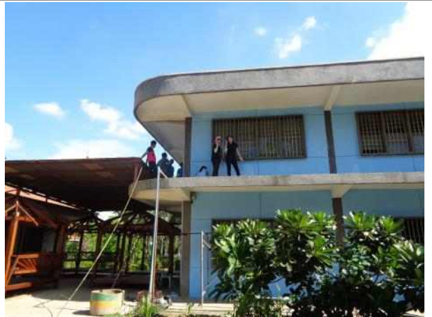
건물 외벽 도색(2016)
