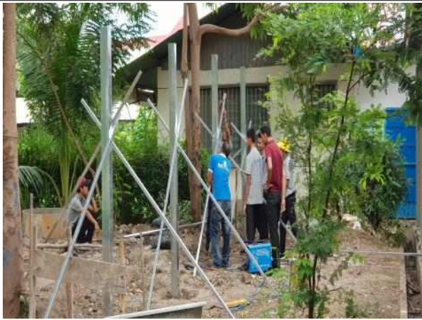
남학생 기숙사 빨래건조장 기초공사(2019)
