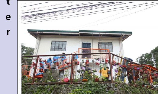
외부 계단 설치, 도색
