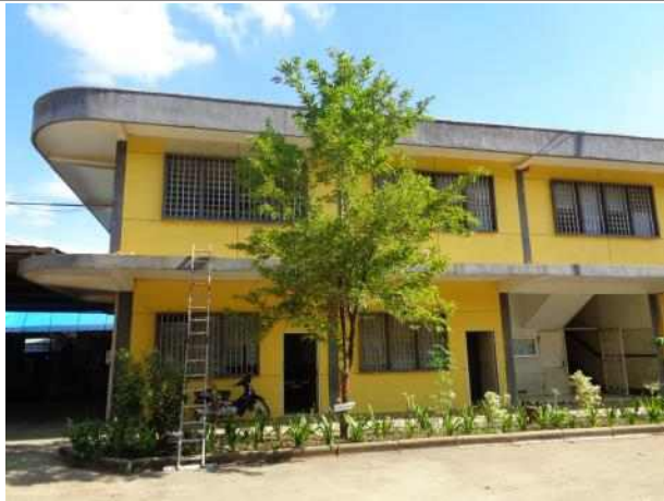
건물 외벽 도색(2016)
